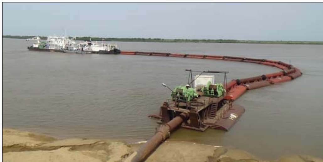
Землесос «Зeya» при выполнении дноуглубительных работ
